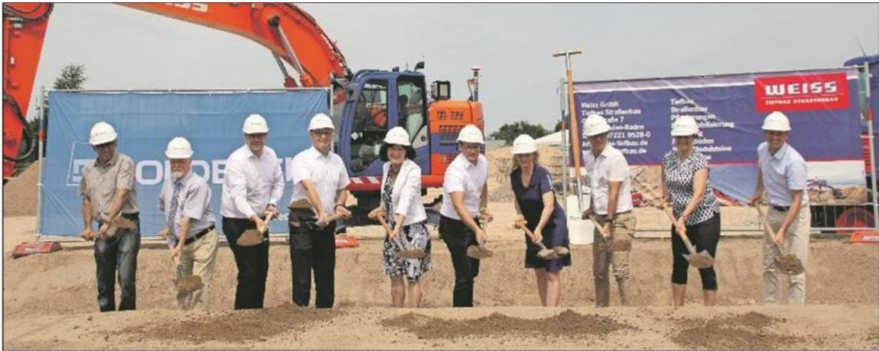
Grund zur Freude: Unter anderem mit den beiden Geschäftsführerinnen und Oberbürgermeisterin Margret Mergen findet der erste Spatenstich statt. Foto: ori
